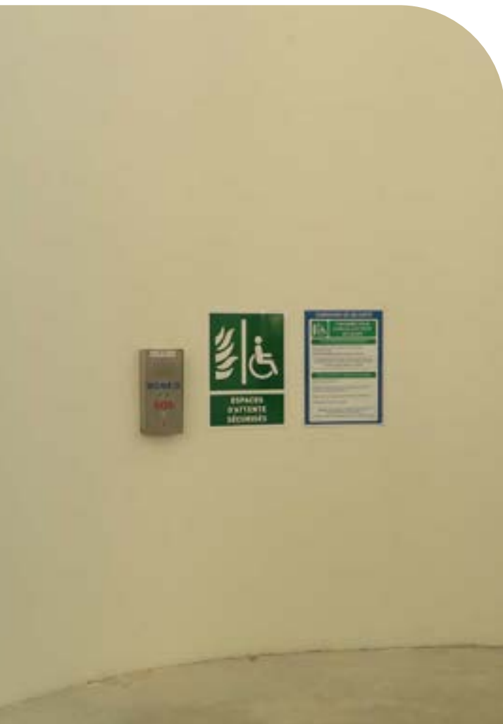
Image 23 | Accessible refuge point at the Stade de Bordeaux
